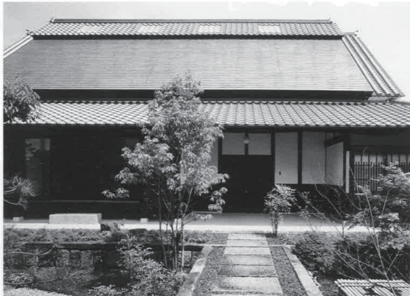
③吹田の民家。150年前に岐阜地方から移築し大和棟に姿を変えた民家を再生
