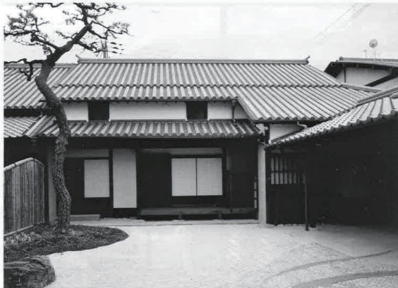
④旧新川家住宅。泉佐野ふるさと町屋館として活用、この地方特有の本瓦の緋(しころ)葺き屋根。修復再生
